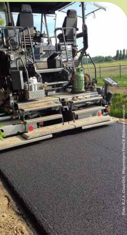
Proefvakken in een weg in Zeeland. Het asfalt bevat de houtstof lignine in plaats van teer.
