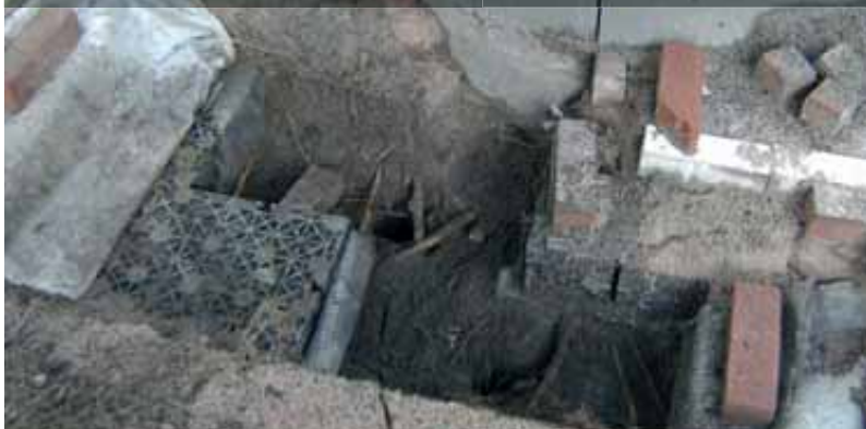
'sandwichconstructie', met onderin het bomenzand met na 4 jaar redelijk dikke wortels. Op het bomenzand komen sterke kratjes met goede grond. Daar bovenop anti-worteldoek, straatzand en klinkers
